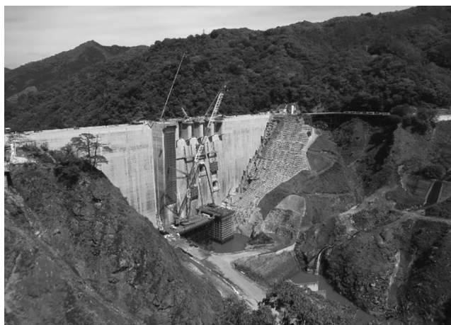
ハッ場見放台よりダム堤 展望台「やんば見放台」より5/22撮影。名勝・吾妻峡の上流部に完成しつつあるダム堤
