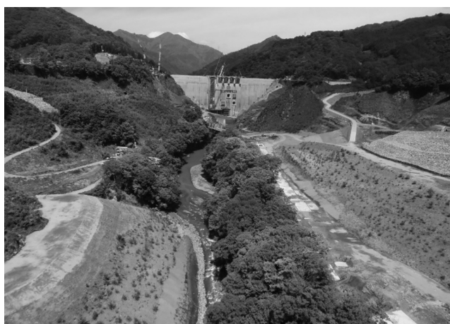
ハッ場ダムと安全対策の押さえ盛り土 ダム堤の左岸側からは地すべり対策の押さえ盛土、右岸側からは川原湯地区の代替地の安全対策の押さえ盛土がせり出している。5/22撮影。
