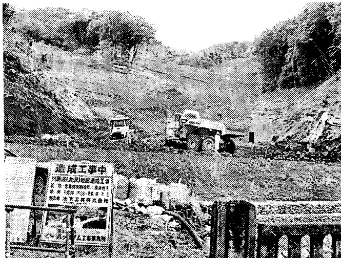
川原湯温泉街代替地 造成工事現場
