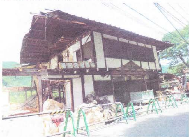
↑2013年夏・解体中の山木館
