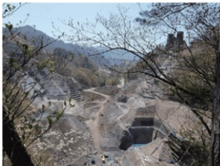
八ッ場ダム本体工事現場 2016.4 「八ッ場あしたの会」HPより
