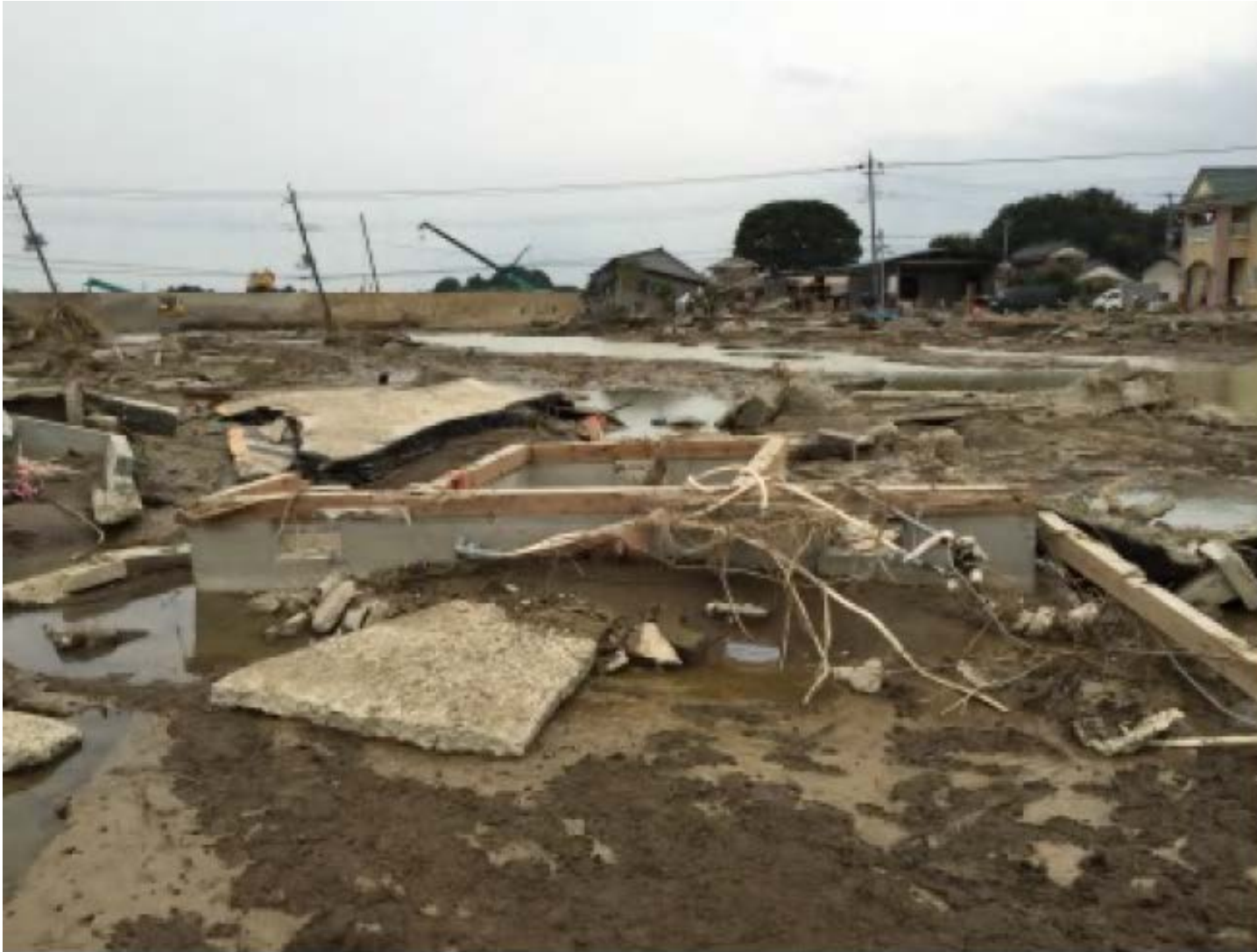
写真10 住宅Eの基礎の一部
