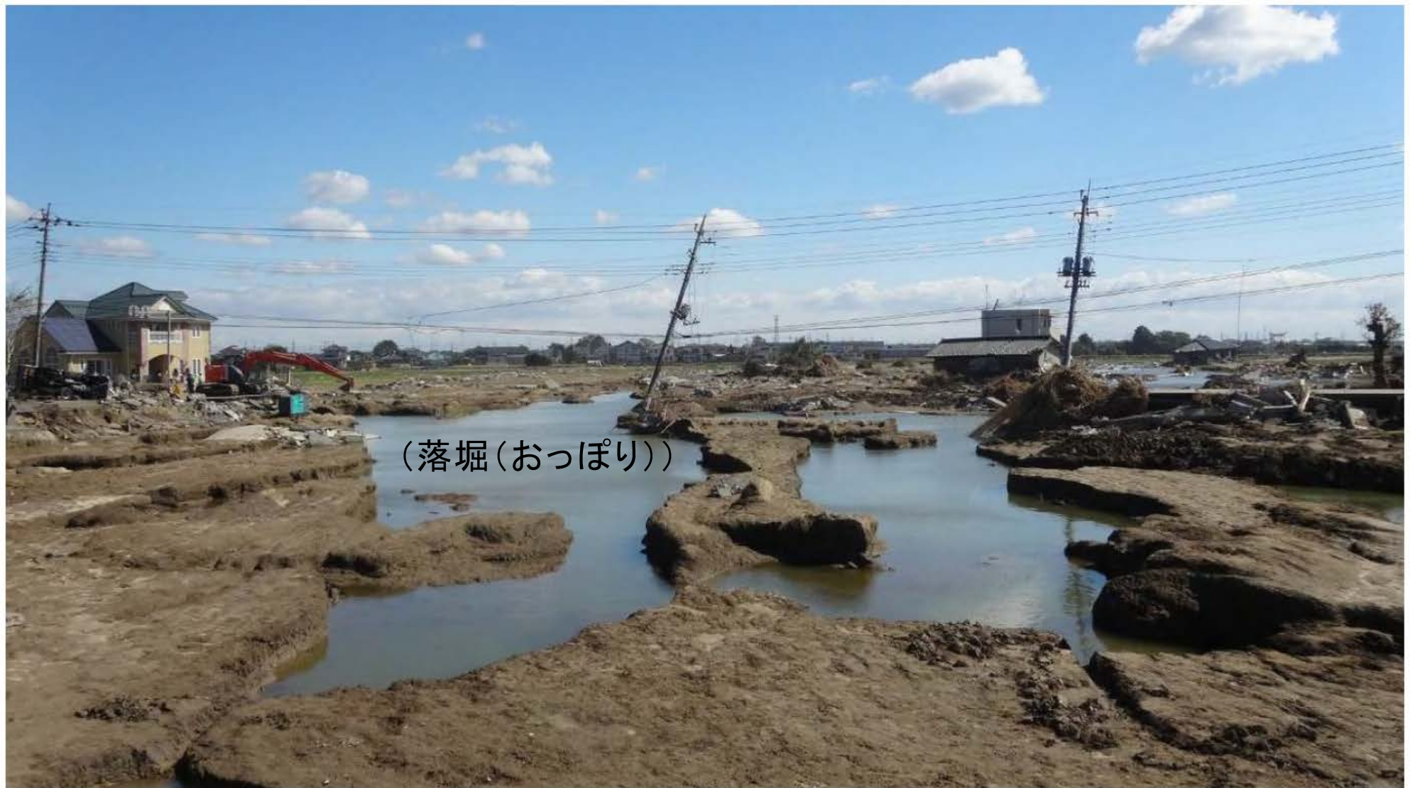
写真45 地盤の侵食状況
